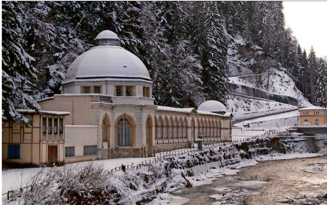
Zeit zu handeln: Der Fels hinter der Trinkhalle droht herunterzustürzen. Bild Fadrina Hofmann
